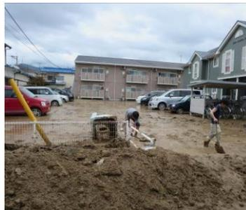
図7 堆積土砂のかき出し作業
