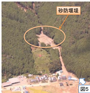
図3 砂防堰堤による効果 2)
