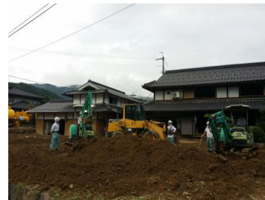
図5 土砂の撤去作業
