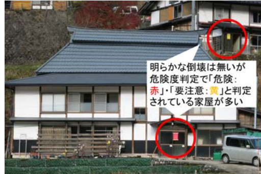
小谷村での建物被害 (小谷村千沢集落)
