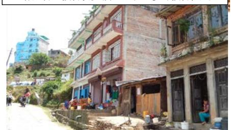
チャウタラ村の被害状況(RC 枠の建物は多く残存)
