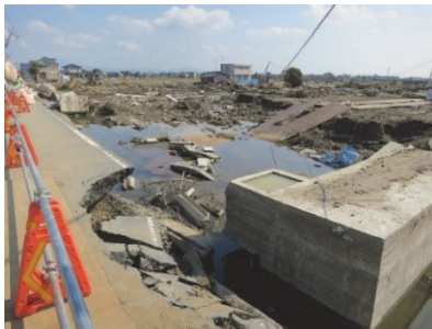
図2 三坂地区周辺の被害状況
