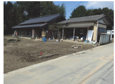
図5 若宮戸周辺の被害状況
