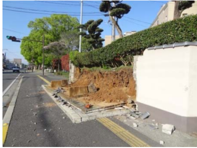
写真7 擁壁の倒壊
