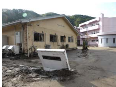
写真1 高齢者施設被災現場
