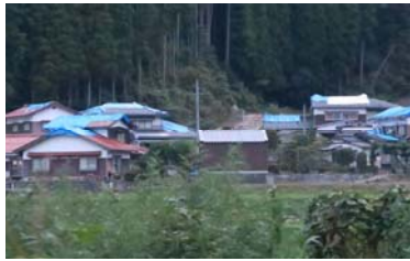
写真 19 集落の被害状況
