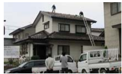
写真 21 ブルーシート展張作業
