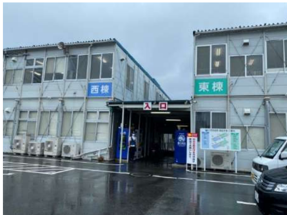
写真4 八代市役所仮設庁舎（7月11日撮影）
