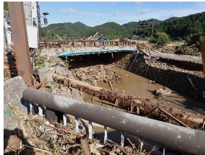
町野地区の被害状況
