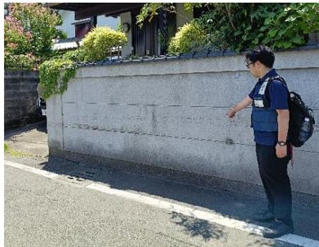
写真2 ブロック塀の浸水痕
