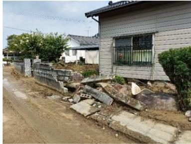
写真10 ブロック塀の倒壊
