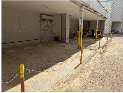
写真 22 建物1階部分の浸水痕
