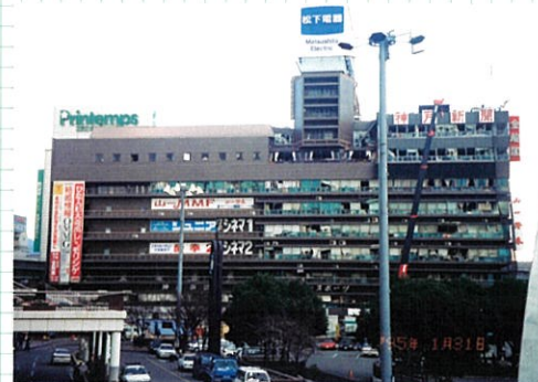
ビル（神戸新聞会館）の被害状況 (資料番号：384-001001-008.00001)
