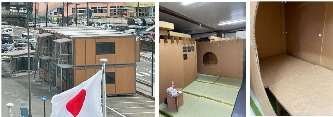
写真 3.3.5 能登町役場玄関前駐車場に建てられた応援職員用プレハブ 内部は畳が敷かれ、段ボールのパーティションが組まれ、個室が作られた
